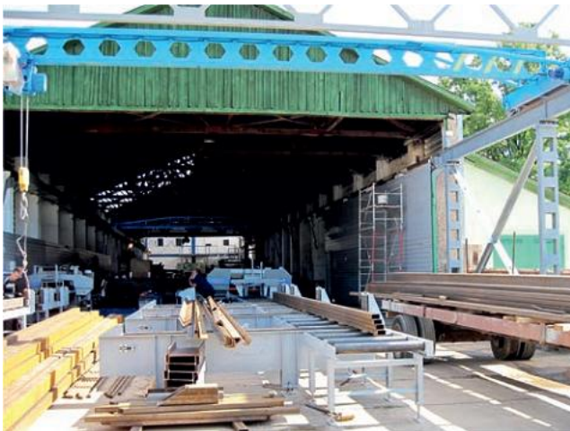
Автоматическая линия на заводе металлоконструкций д. Солтановка, Беларусь.
